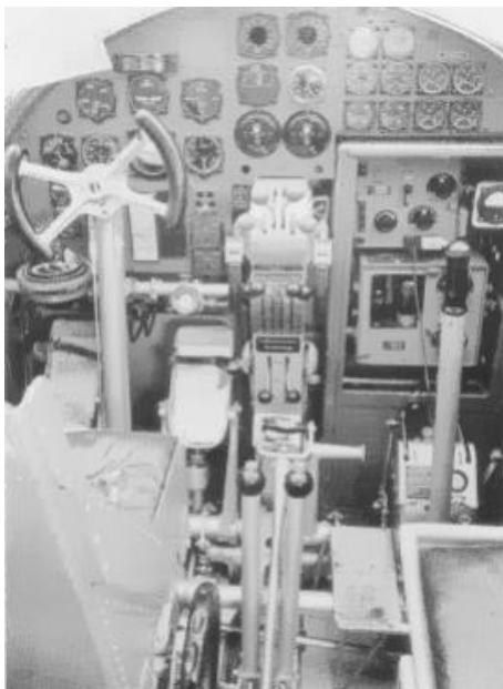
Führersitz der He 111 C. Im Durchgang zum Platz des Bombenschützen befanden sich Funkgeräte, die aber entfernt werden konnten.
